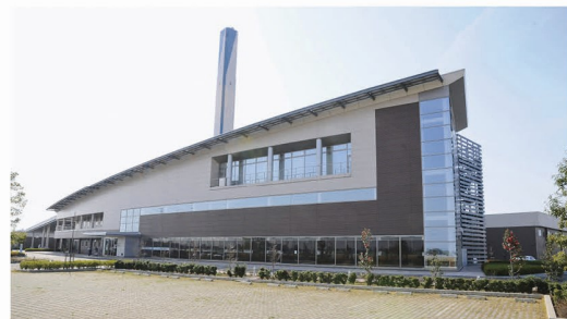
環境プラザ「つばさ館」
