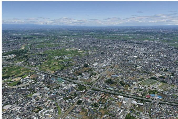
関越自動車道川越インターチェンジ
