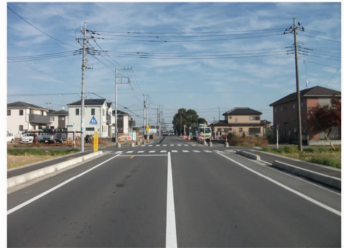
拡幅中の広域幹線道路 （市道0023号線）
