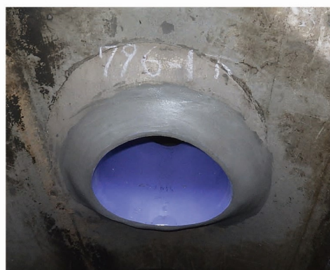
污水管きよ更生工事（施工後）
