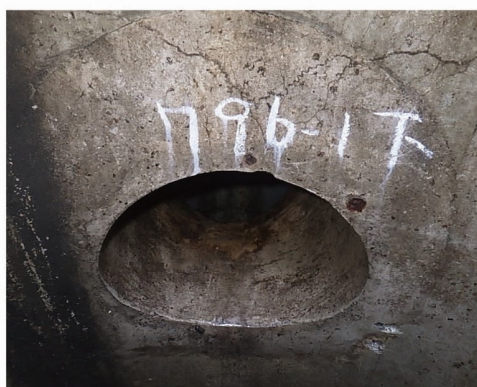
污水管きよ更生工事（施工前）
