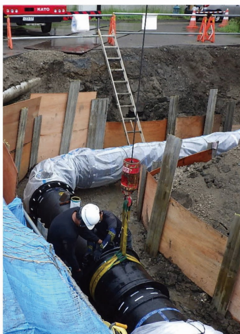
浄水場内の配水管布設工事
