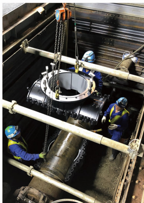
不断水バルブの設置工事
