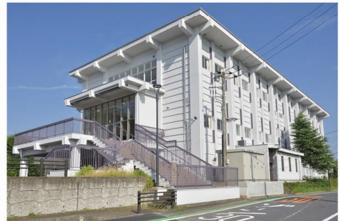
耐震改修後の武道館
