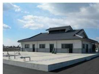
鴨田農業集落排水処理施設
