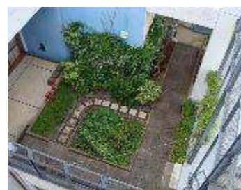
屋上緑化(クラッセ川越)
