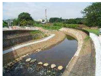
多自然型護岸(笠幡地区)
