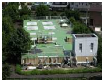
久保川水質浄化施設
