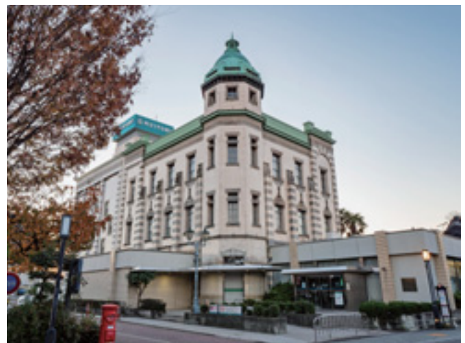
旧第八十五銀行本店本館（埼玉りそな銀行旧川越支店）
