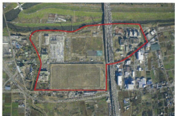
新河岸川水循環センター
