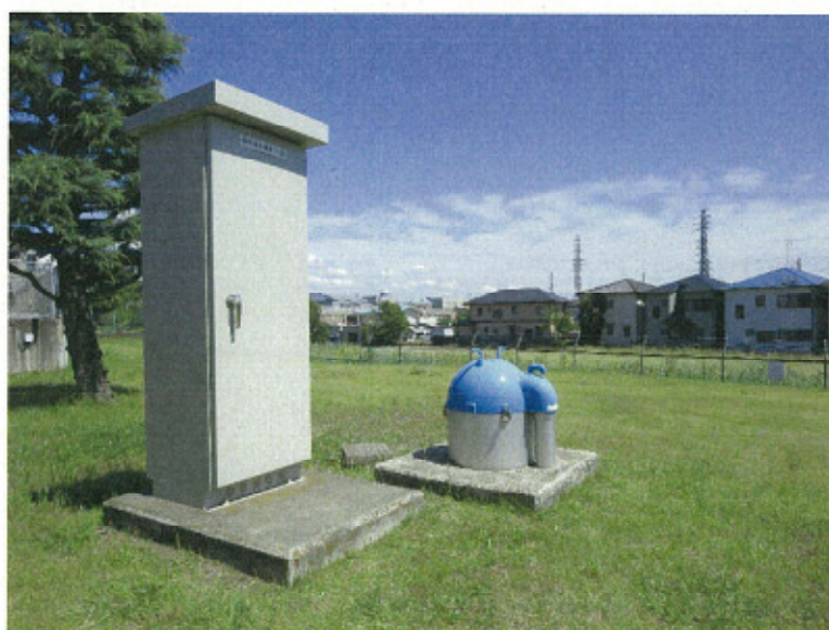
郭町浄水場第1水源
