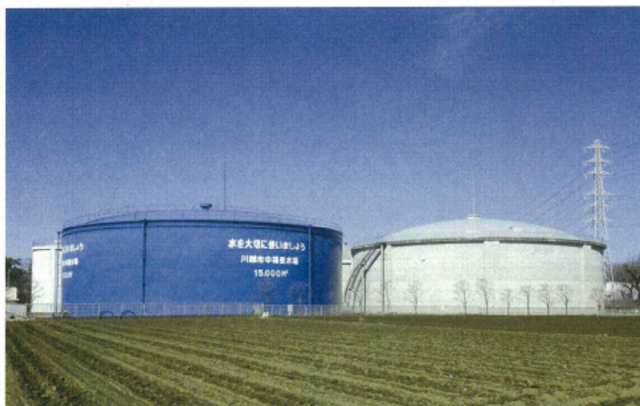
中福受水場配水池
