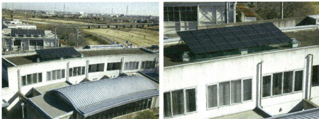
太陽光発電システム（上下水道管理センター屋上）
