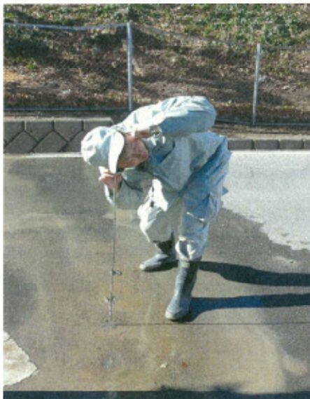
音聴棒を使った漏水調査
