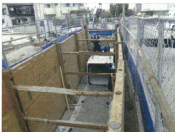
雨水管きよの整備
