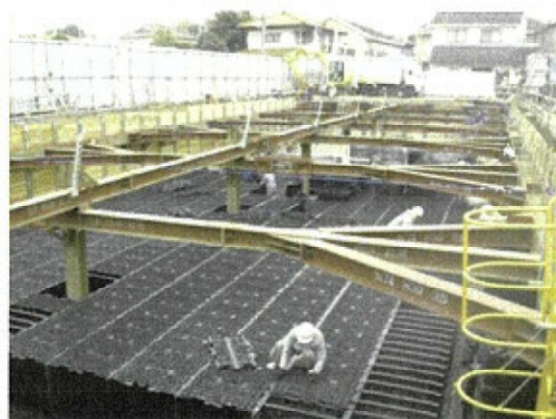
雨水貯留施設の整備
