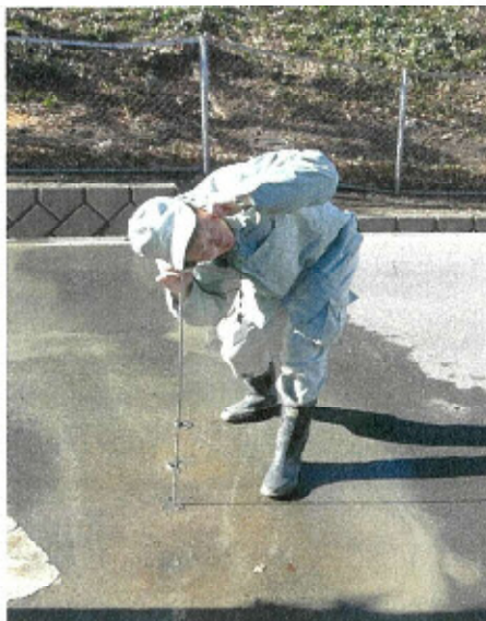
音聴棒を使った漏水調査
