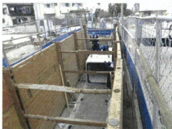
雨水管きよの整備
