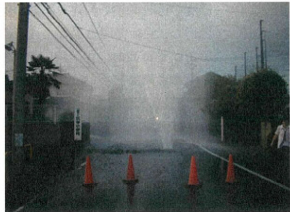
2008年8月の漏水状況
