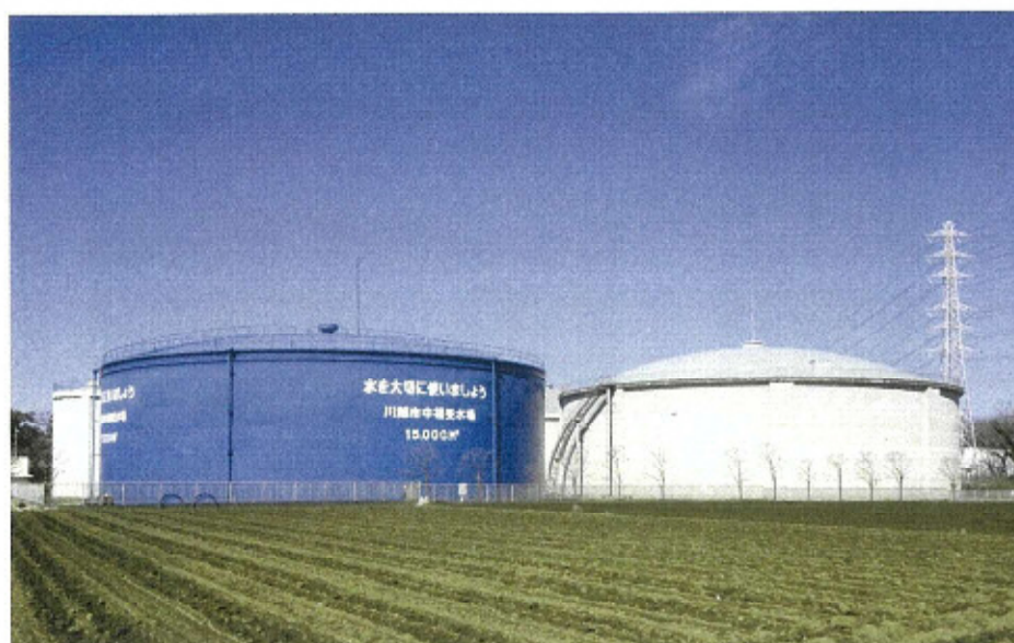
中福受水場配水池
