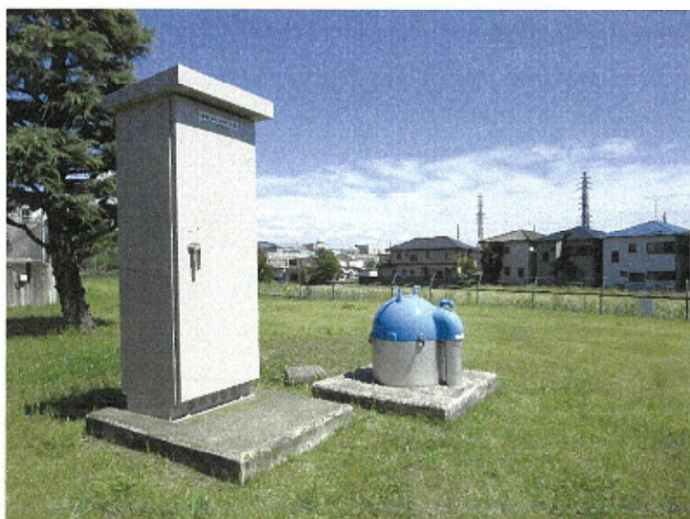
郭町浄水場第1水源
