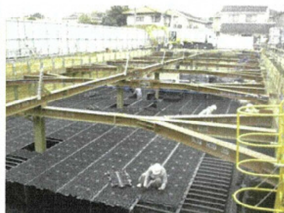
雨水貯留施設の整備
