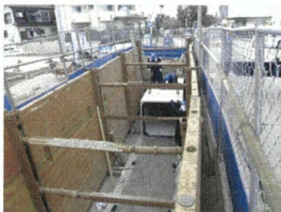
雨水管きよの整備
