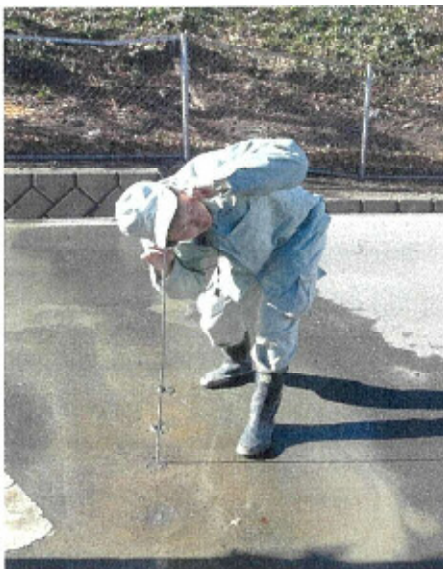
音聴棒を使った漏水調査
