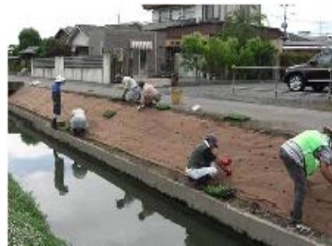
水路のり面の保全の様子
