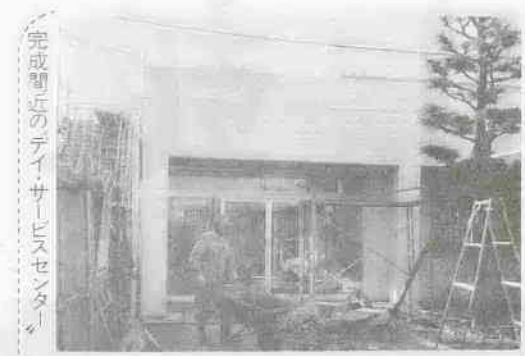
完成間近のデイ・サービスセンター
