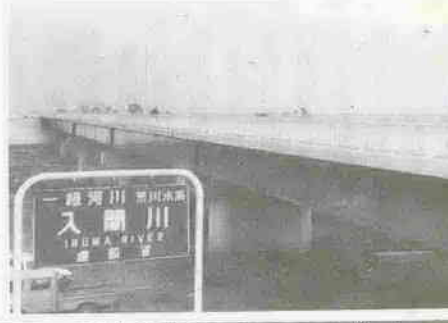
落合橋の完成
