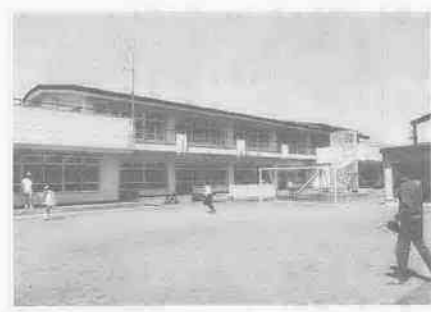
▲障害児合同通園施設
