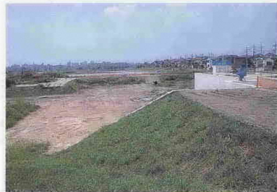
建設が進む寺尾調節池 (7月撮影)
