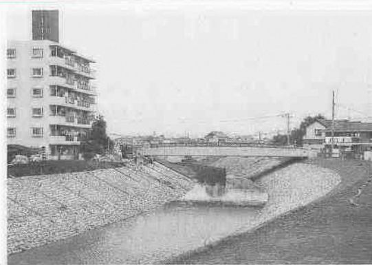
河川改修が進む不老川、新河岸川合流地点付近
