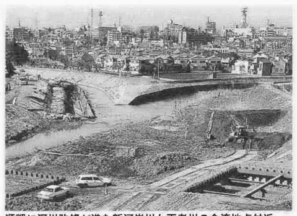
順調に河川改修が進む新河岸川と不老川の合流地点付近
