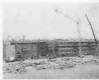
建設が進む霞ヶ関北小学校等複合施設
