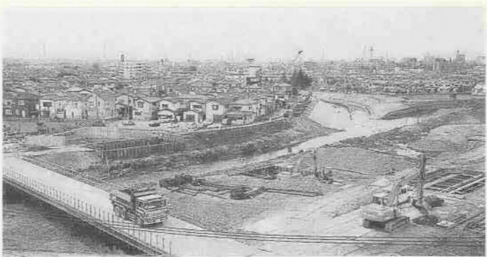
河川改修工事が進む不老川と新河岸川の合流地点(砂中学校屋上から撮影)
