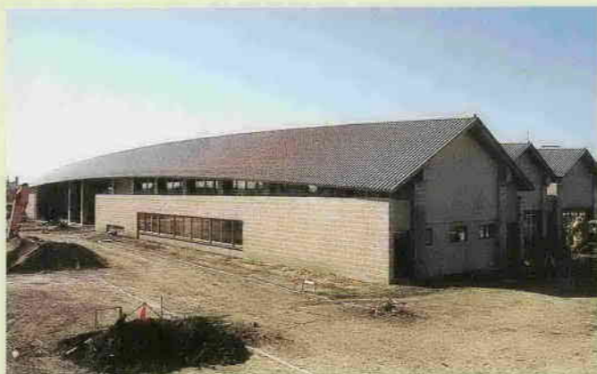
7月オープンを目指して建設が進む仮称葬祭会館
