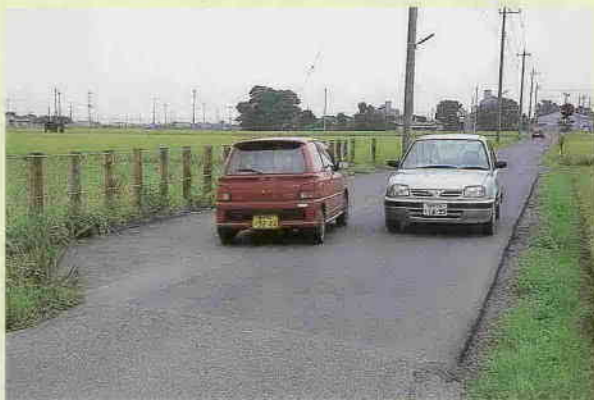
生活道路の一部を拡幅した「ゆずりあい道路」
