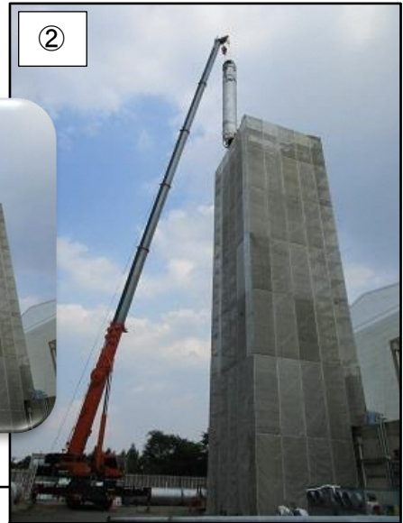
② 煙突解体作業中の様子です。
