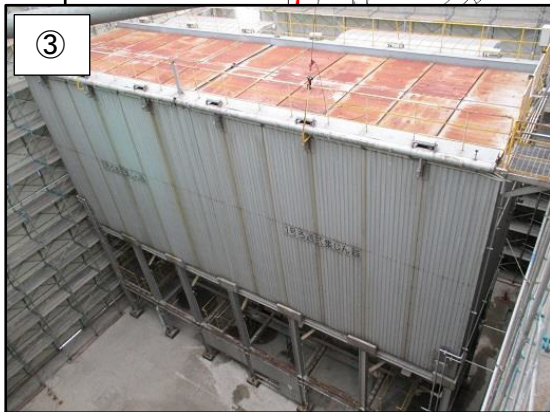
③ 機器解体前の仮設テント内部の様子です。
